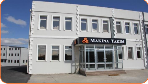
Üretim Tesisi / Fabrika Genel Merkez
