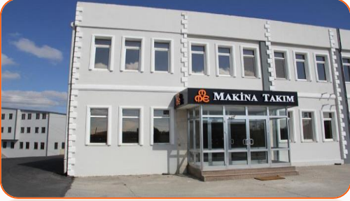
Üretim Tesisi / Fabrika Genel Merkez
